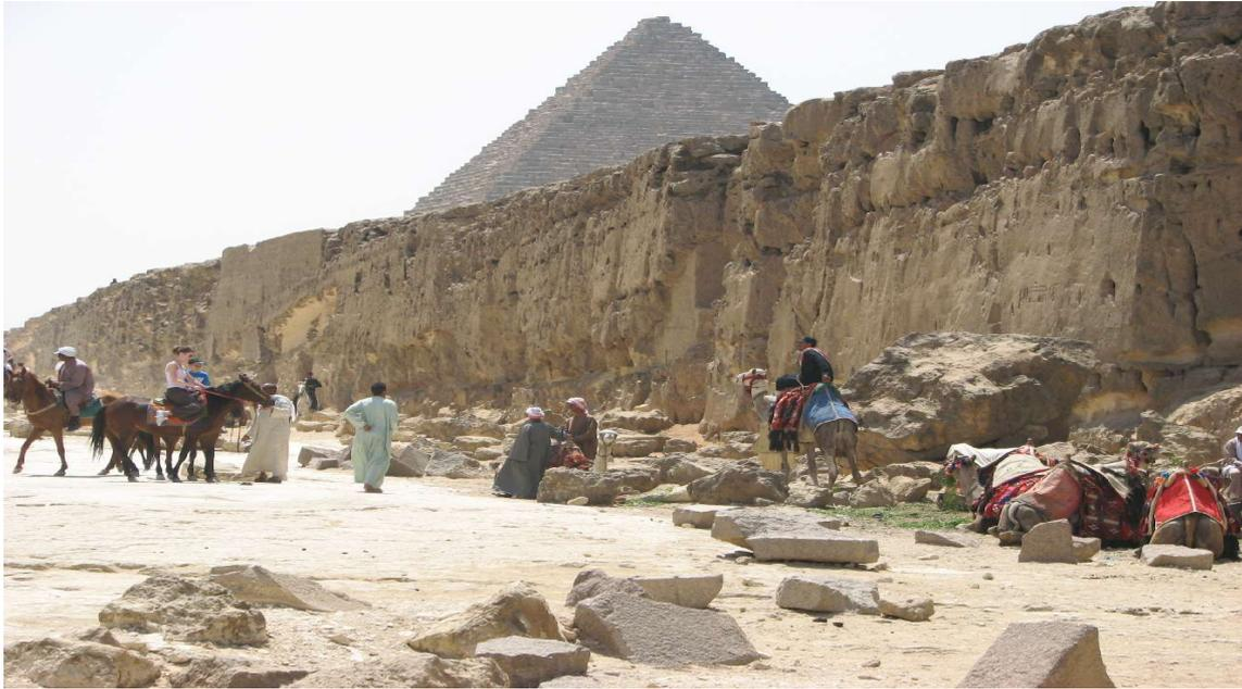
Los escalones excavados del núcleo tienen unas dimensiones aproximadas de 1,00 a 1,1 m de altura, excepto en la fila inferior que es de 1,20 a 1,40 m. La primera hilera o escalón muestra subdivisiones
