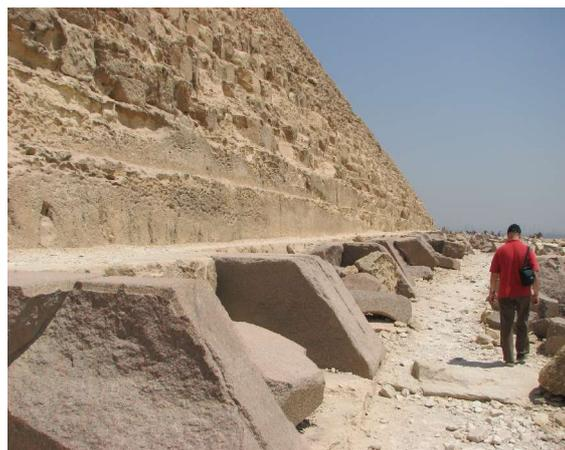
Como ya hemos mencionado, estos bloques dispuestos menos regularmente se encuentran sobre los escalones del núcleo interior de la pirámide, y como puede verse en muchos puntos de la cara O, muestran pequeños bloques de relleno, e incluso mortero de cementación entre ellos.
